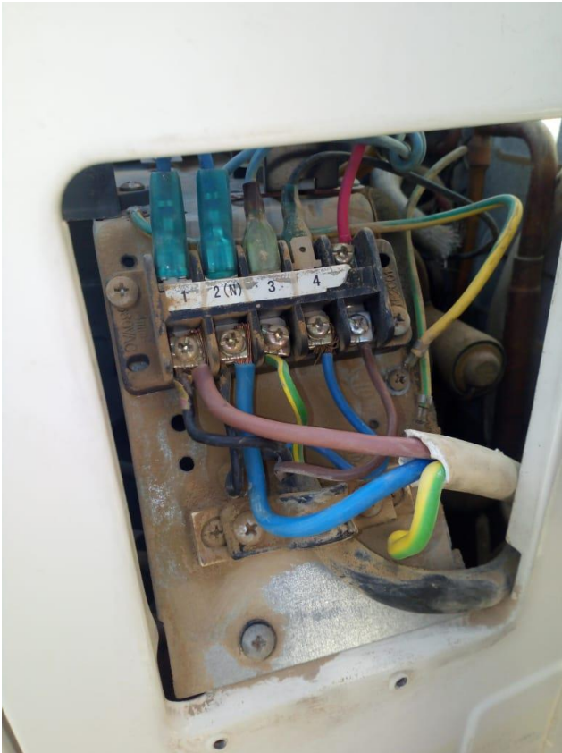
التوصيلات الكهربائية للوحدة بعد تنفيذ مقترح تركيب كونتاكطور
