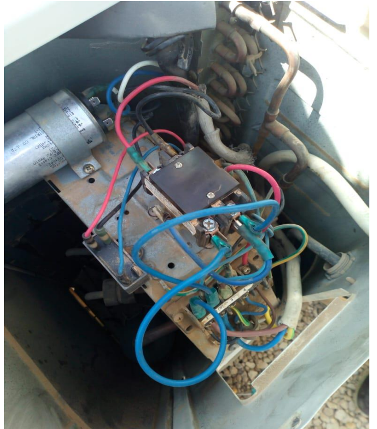
التوصيلات الكهربائية للوحدة بعد تنفيذ مقترح تركيب كونتاكطور
